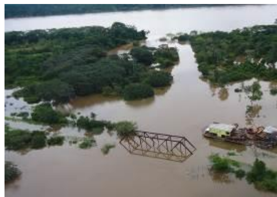
Ponte da Estrada de Ferro Madeira Mamoré (EFMM) inundada (a montante das usinas)
