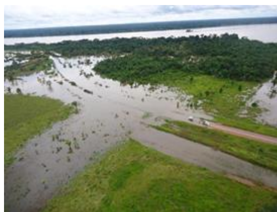
Imagem aérea da Rodovia BR 364 inundada (a montante das usinas)
