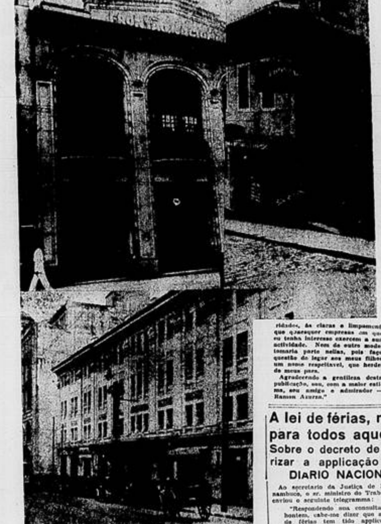
As tres esplanadas localizadas no centro da cidade, que, teitadamente, não se reabrirão.
