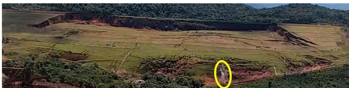
Figura 11 – Vista Frontal do início do rompimento da Barragem 1 – círculo amarelo realça o jorro de água saindo na parte baixa do Maciço - Mina Córrego do Feijão, Complexo Paraopeba - VALE S. A. , Brumadinho/MG. Fonte: B1 – CAM1 – BARRAGEM – 25.01.2019 – 12:28:30
