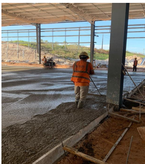
Figuras 20 e 21: trabalhadores da Jinjiang em atividade de concretagem
